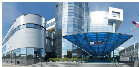
Здание АК Транс-Нефть
